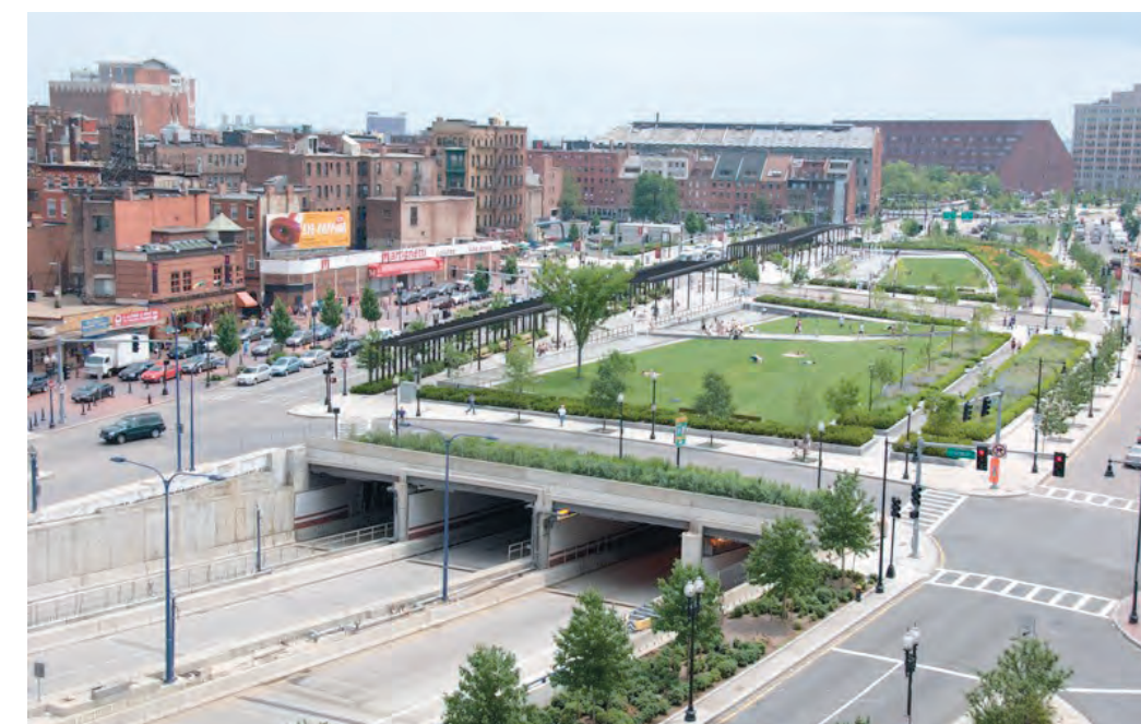
ALGUNAS A TRAVÉS DE TÚNELES
