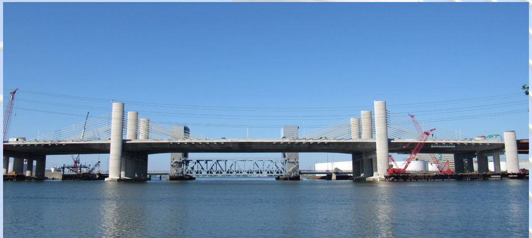
El Puente Pearl Harbor Memorial, también conocido como el Puente Q, atraviesa el río Quinnipiac entre New Haven y East Haven. Es el primer puente sofisticado del país que combina diseños con cables atirantados y de cajón con vigas.
