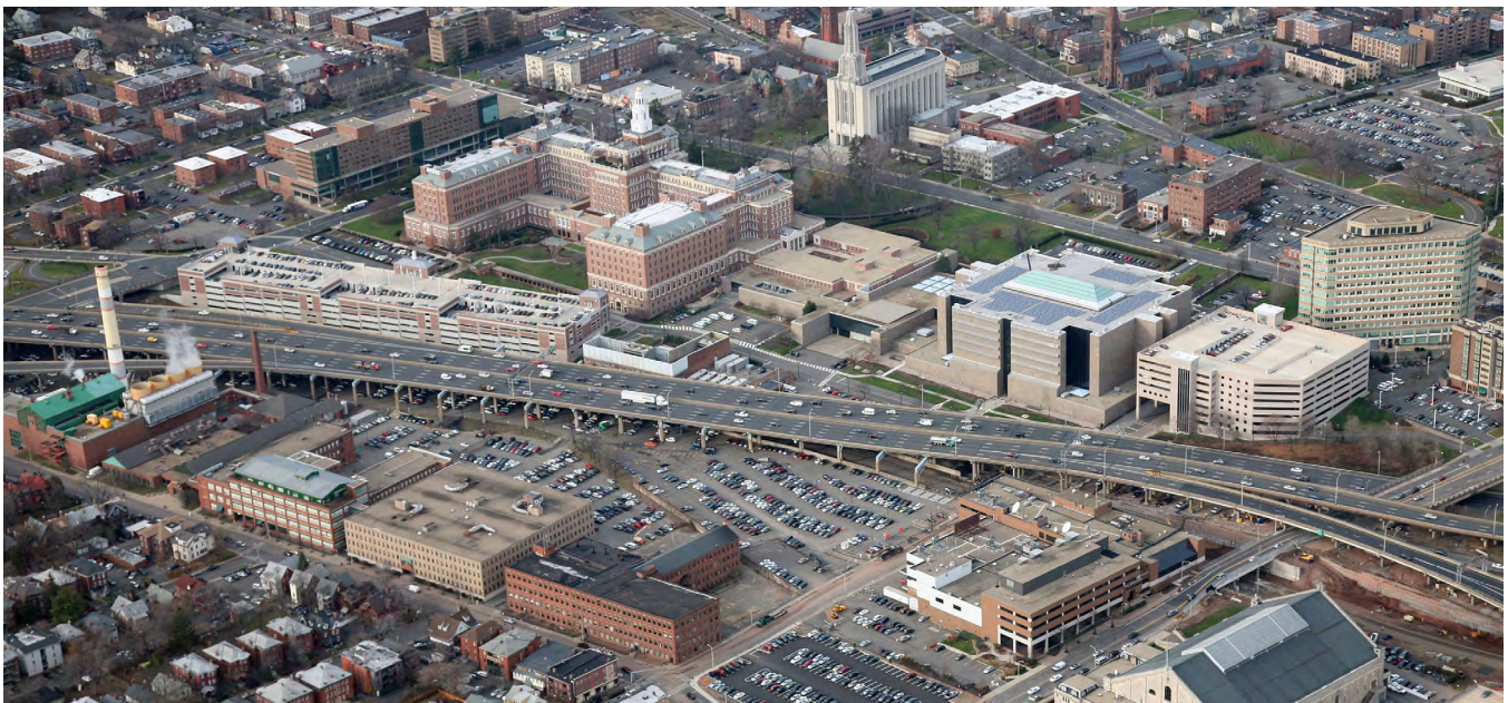
Vista aérea de parte del viaducto de la I-84 a su paso por Hartford.
